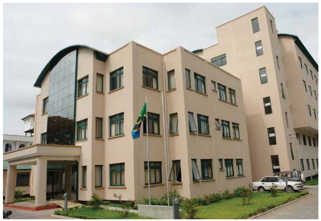
Jengo la Ofisi ya Makamu wa Rais lililopo katika mtaa wa Luthuli, Dar es Salaam.
